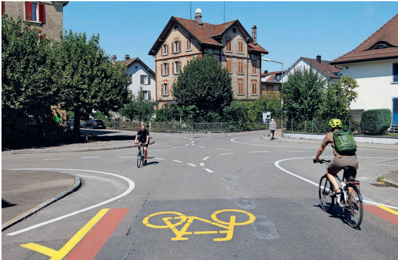
8 | Wegen Sicherheitsbedenken blieben bei der Veloroute Töss (hier Dammstrasse) zwei Knoten mit Rechtsvortritt bestehen. (Foto: Dominique Meienberg, Tiefbauamt Stadt Winterthur)
