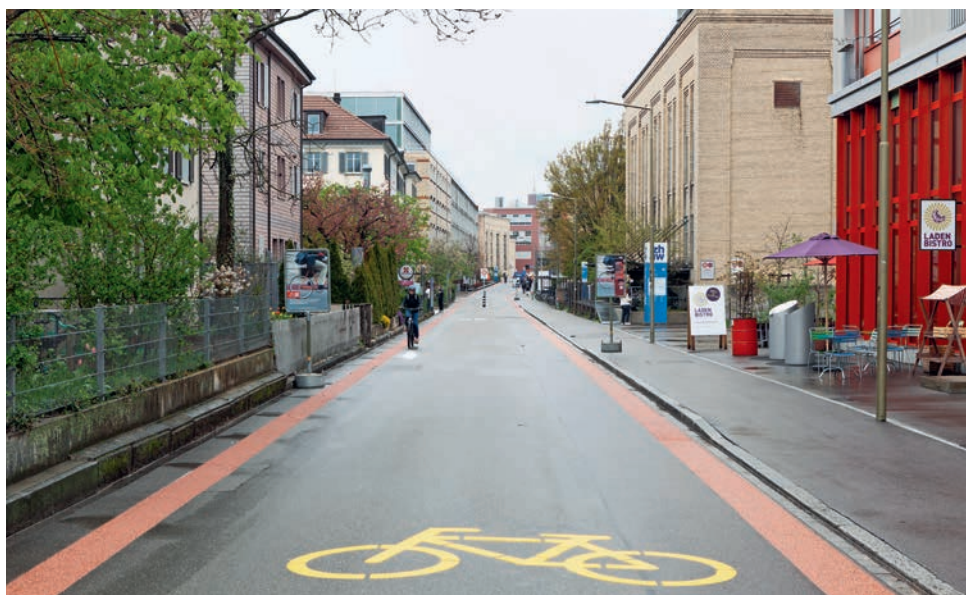
10 | Die beidseitigen roten Bänder und das gelbe Piktogramm sollen die Veloroute klar erkennbar machen.
