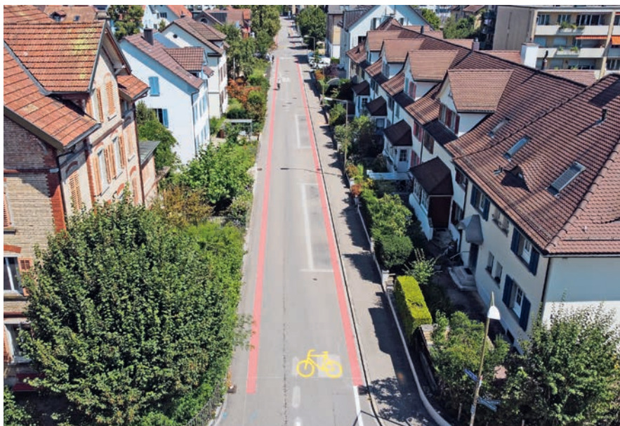
13 | Entlang der Veloroute Töss wurden die markierten Parkfelder zugunsten der Verkehrssicherheit entfernt. (Foto: Marcus Schmid, Tiefbauamt Stadt Winterthur)
