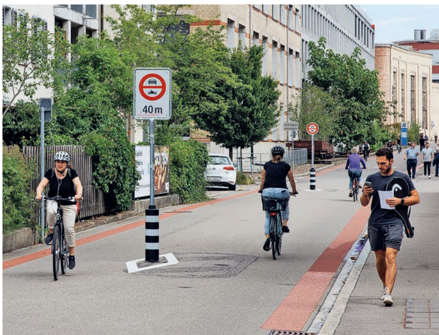
14 | Zwingend erforderliche Signale wurden für eine bessere Erkennbarkeit und als Richtungstrennung für den Veloverkehr in der Fahrbahnmitte platziert und mit einer weissen Markierung umrandet. (Foto: Dominique Meienberg, Tiefbauamt Stadt Winterthur)
